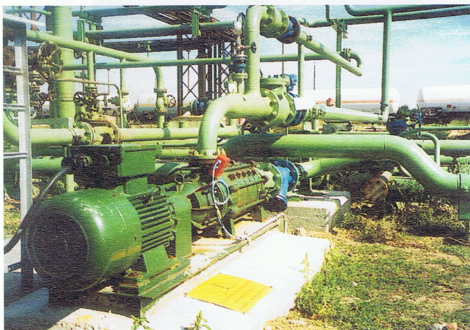
1: Flüssiggaspumpe mit Mag-Safe-Überwachung zur Auslagerung von Propan/Butan im Raffineriebetrieb
